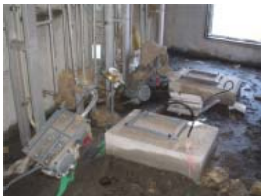
写真-4 機械設備の被害状況
