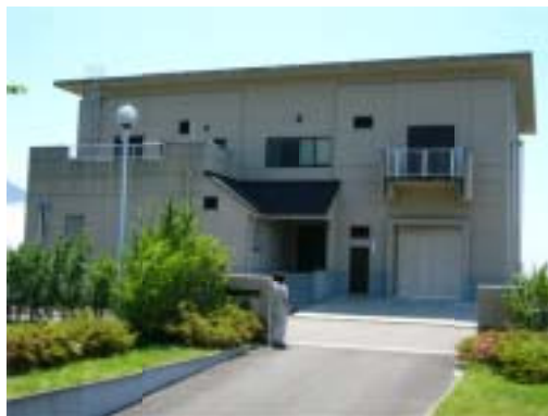
写真-1 漁業集落排水処理施設
