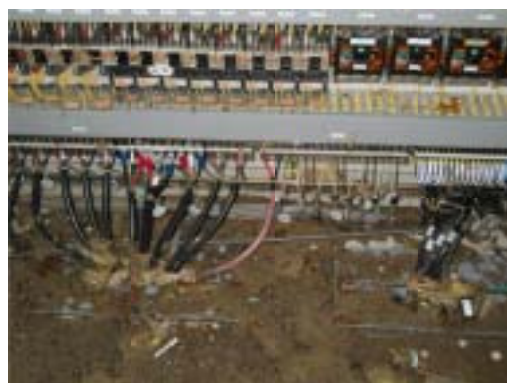
写真-5 電気設備の被害状況
