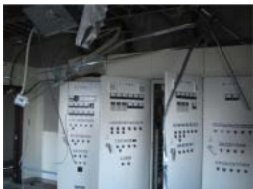
写真-5 電気設備の被害状況
